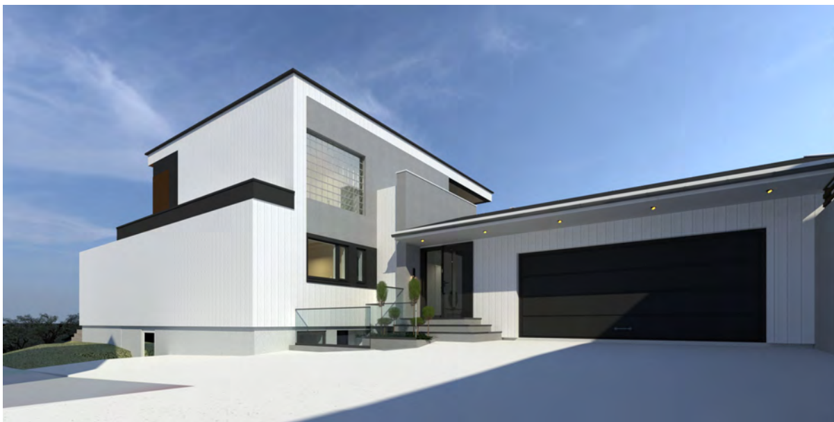
Fasade mot nord, inngangsparti.
